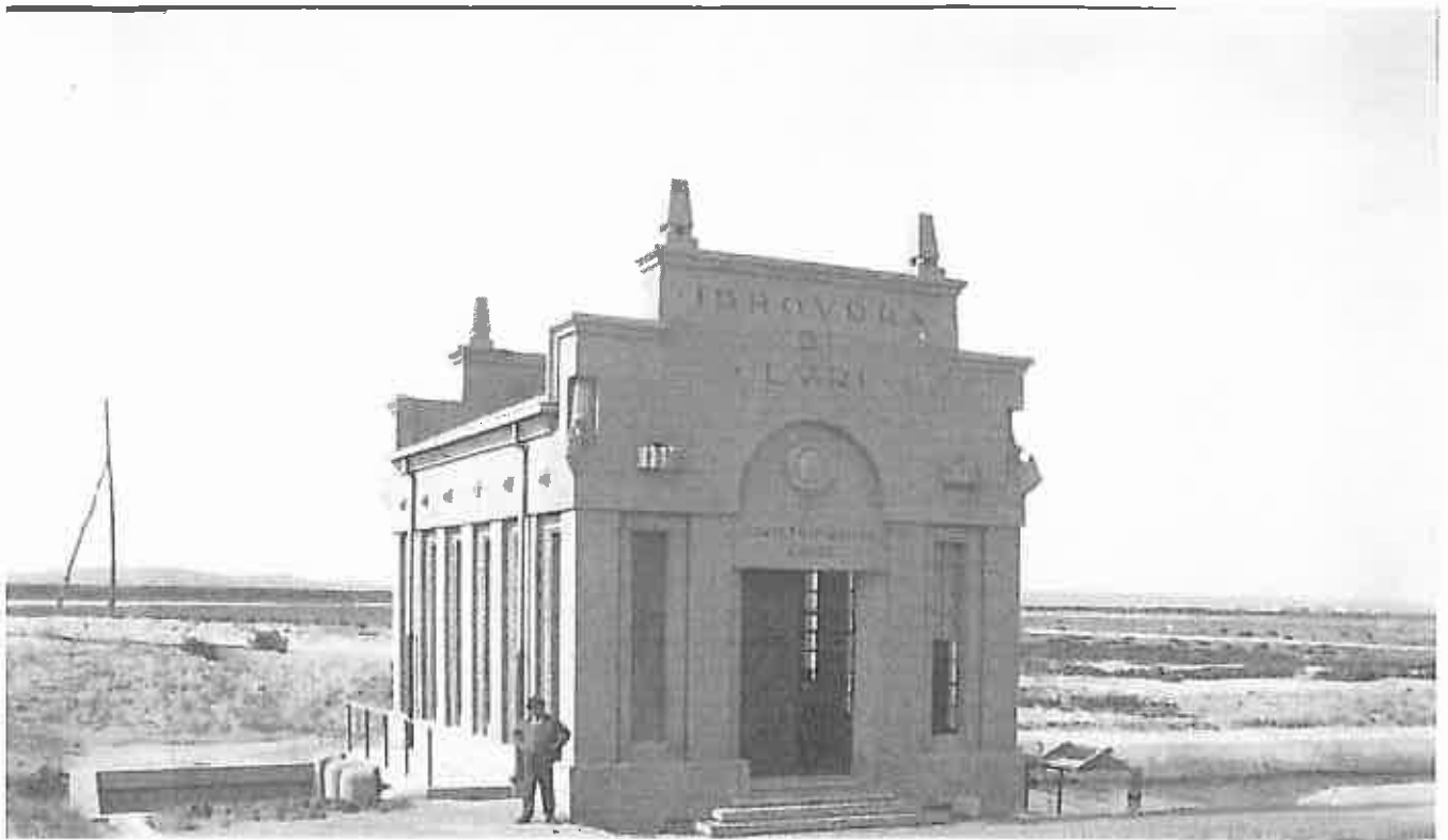
Prospetto principale Idrovora di Luri - foto storica (Archivio SBS)
