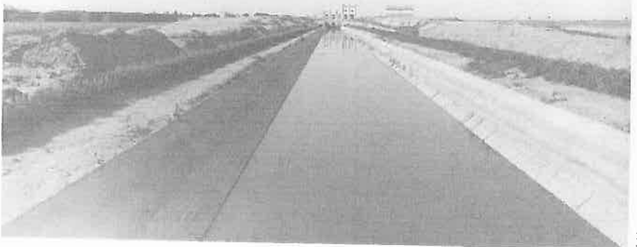
Canale intake e Idrovora Principale di Sollevamento Foto storica (Archivio SBS)
