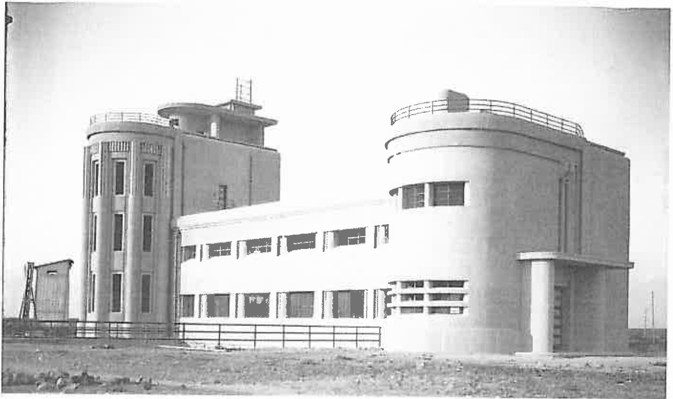
Foto storica prospetto principale Idrovora di Sassu (Archivio SBS)
