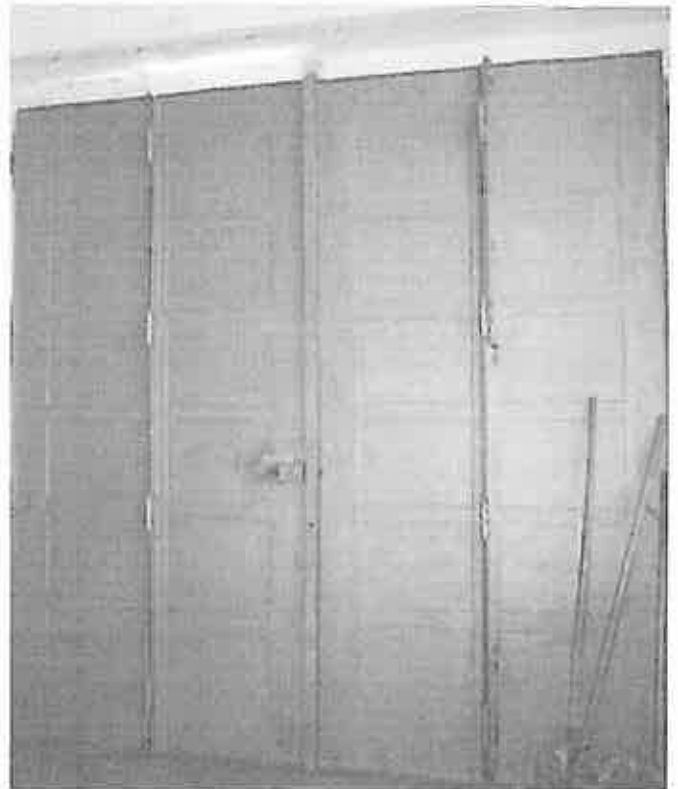
Portone ingresso corpo sinistro
