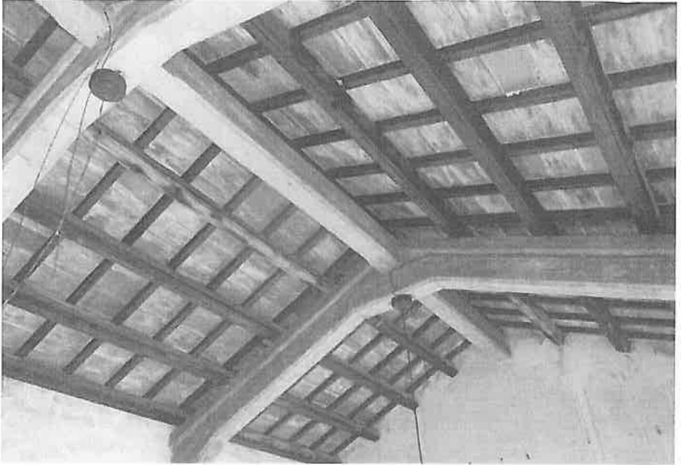
Copertura in cemento armato e legno
