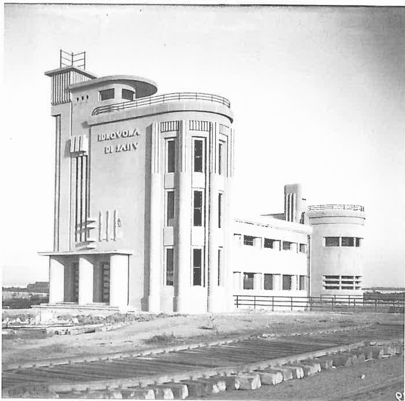
Foto storica prospetto principale Idrovora di Sassu (Archivio SBS)
