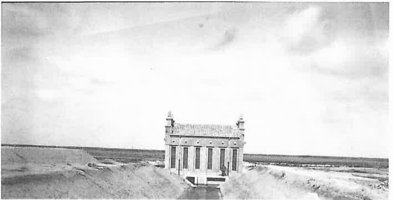
Prospetto laterale Idrovora di Luri - foto storica (Archivio SBS)
